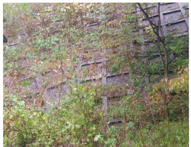
既存施設の状況確認
