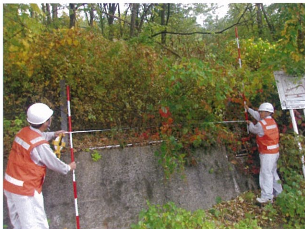
落石防護柵の点検
