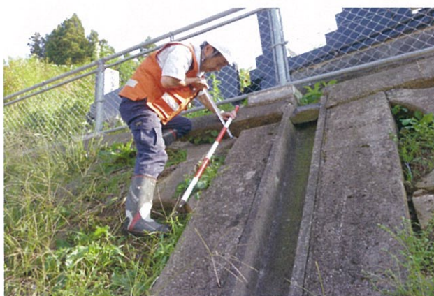
施設点検の状況
