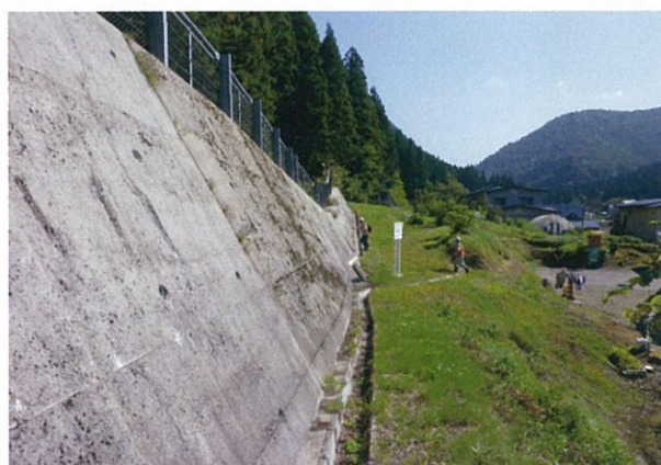
施設点検の状況
