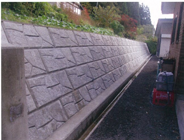
崩壊防止施設の状況確認
