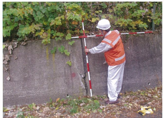
施設点検の状況
