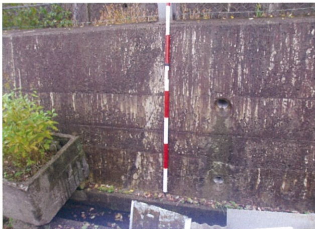
施設点検の状況
