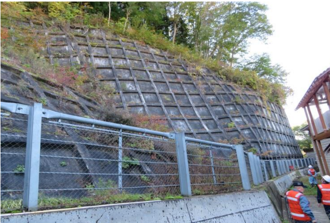
斜面点検の状況
