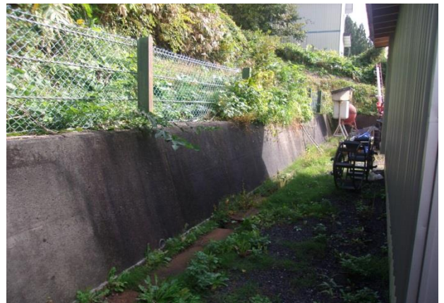
崩壊防止施設の状況確認
