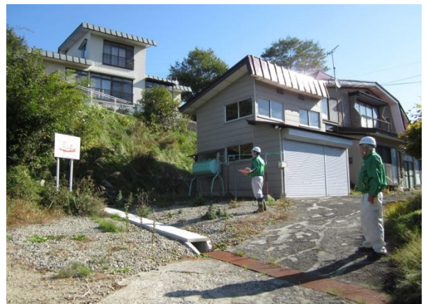
斜面点検の状況
